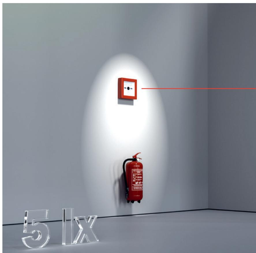
Nichtautomatische Brandmelder müssen in einer Höhe von 140 cm ( $\pm$  20 cm) über dem Boden angebracht sein.
